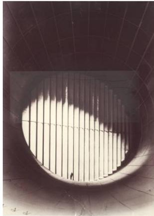
Vannes de guidage de l'écoulement (Ø = 24 m)
